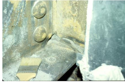
Figura 18. Ejemplos de daños en las uniones viga-columna de pórticos de acero.
