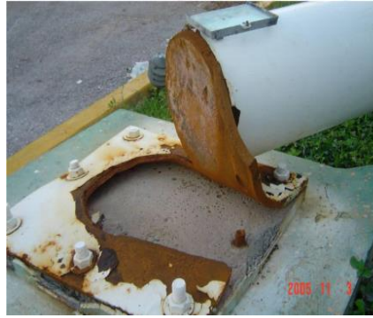
Figura 21. Ejemplos de daños en el apoyo de columnas de acero.
