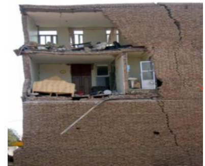
Figura 22. Ejemplos de daños en edificios de mampostería estructural.
