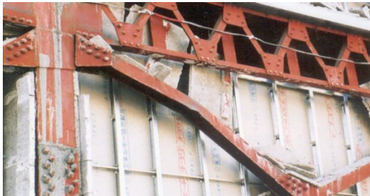
Figura 20. Ejemplos de daños en diagonales de arriostramiento en pórticos arriostrados de acero. El pandeo en el arriostramiento de la izquierda es representativo del desempeño esperado que permite disipar energía por ese mecanismo.
