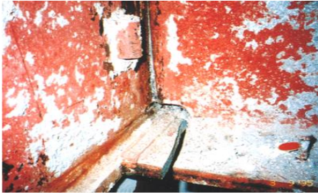
Figura 18. Ejemplos de daños en las uniones viga-columna de pórticos de acero.
