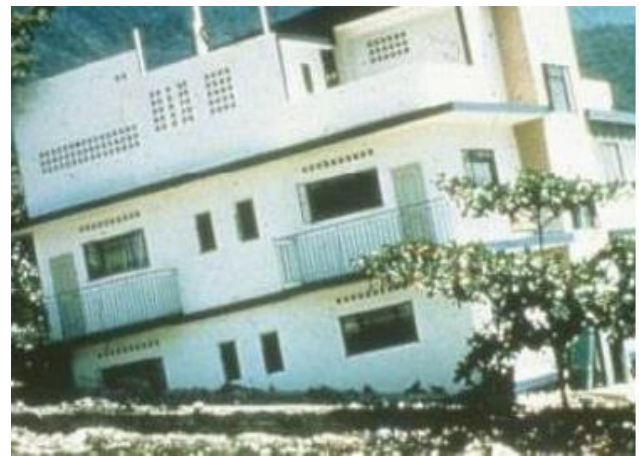
Figura 8. Ejemplos de asentamientos de Edificios.
