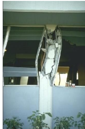
Figura 12. Ejemplos de daños en columnas de concreto armado.
