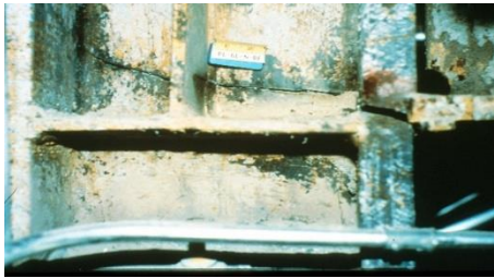
Figura 19. Ejemplos de daños en columna y en viga de pórticos de acero.
