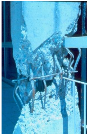
Figura 12. Ejemplos de daños en columnas de concreto armado.
